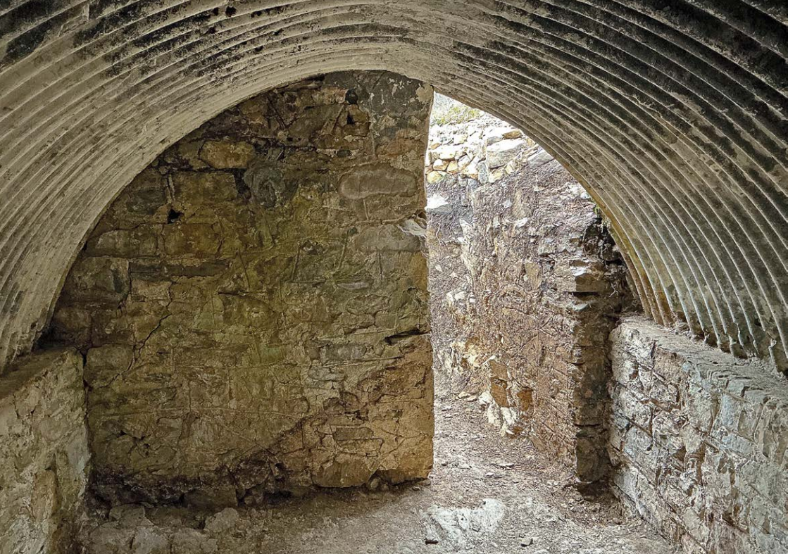
Abrigo de tropa del Collado del Hielgo | Entrada del primer abrigo, visto desde el interior.
