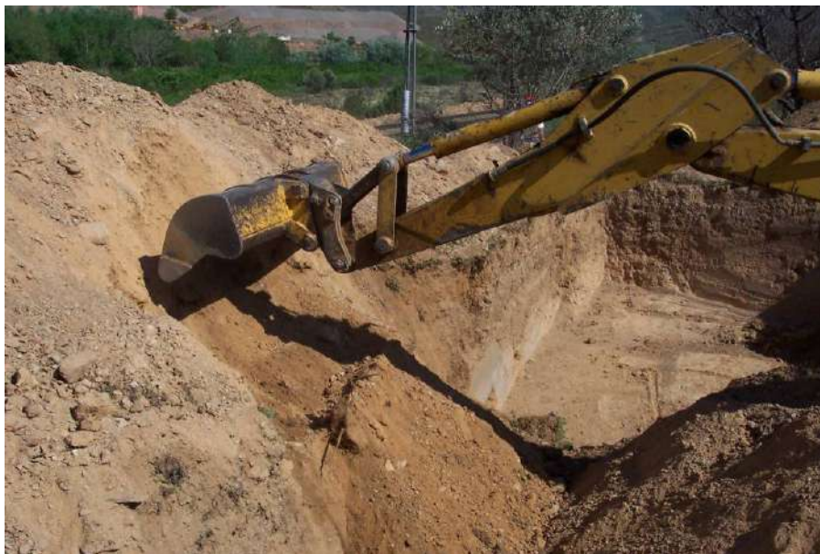
Utilización de medios mecánicos en cata 3
